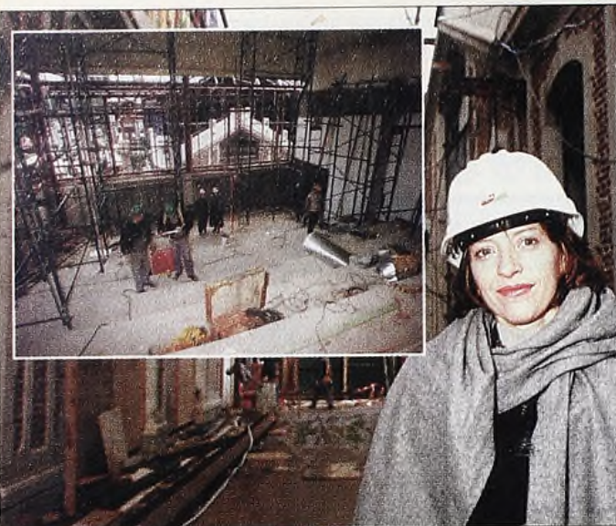
Isabel Clavier: "En 'El Solar de la Abadía' se respetó la arquitectura original del edificio. Los dos cines que se van a inaugurar acá se sumarán a la tendencia mundial de proyección de películas en este tipo de lugares".
