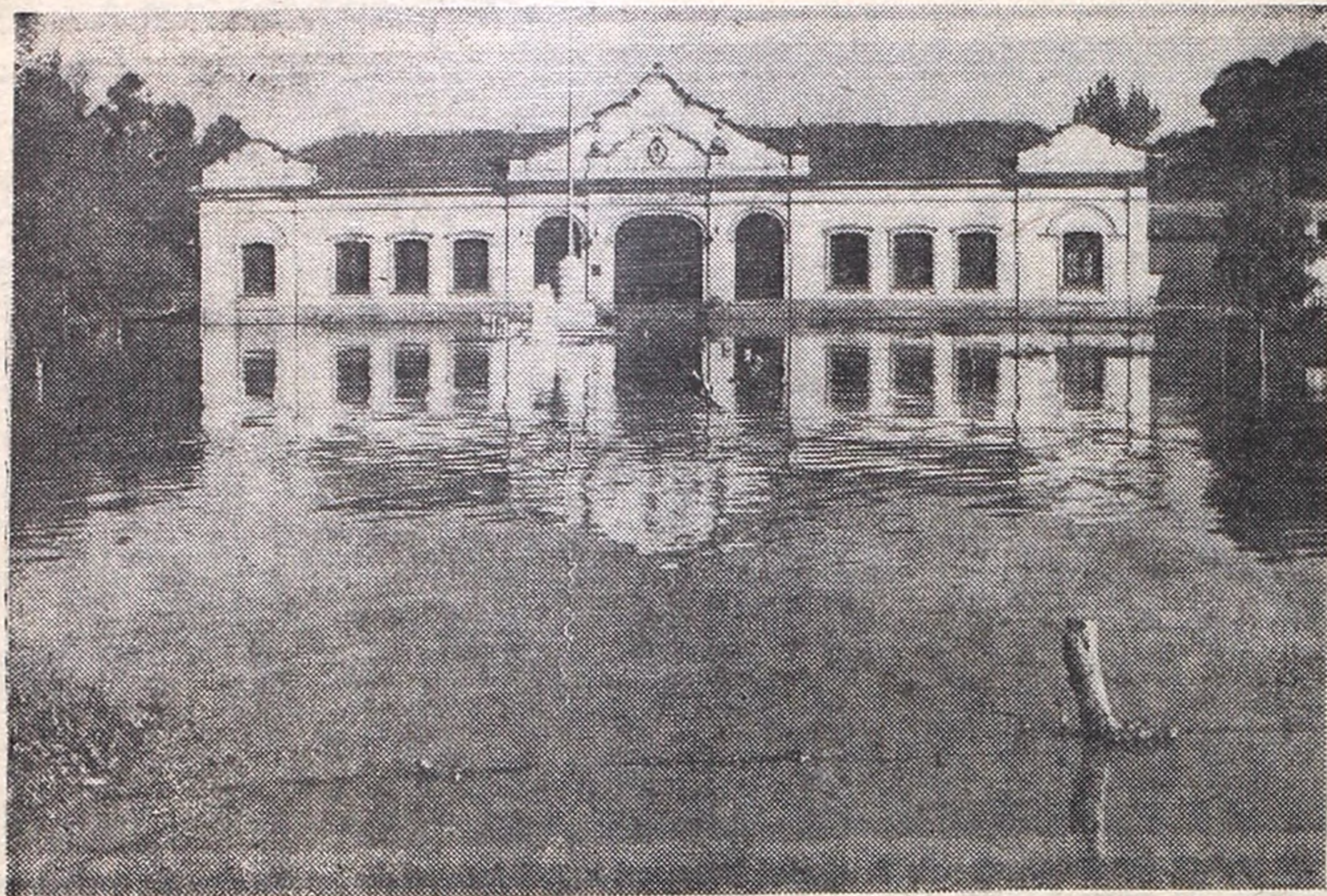
Las aguas llegaron con su zozobra a la localidad bonaerense de Baradero. Aquí vemos las instalaciones del Club de Tiro completamente anegadas por las aguas
