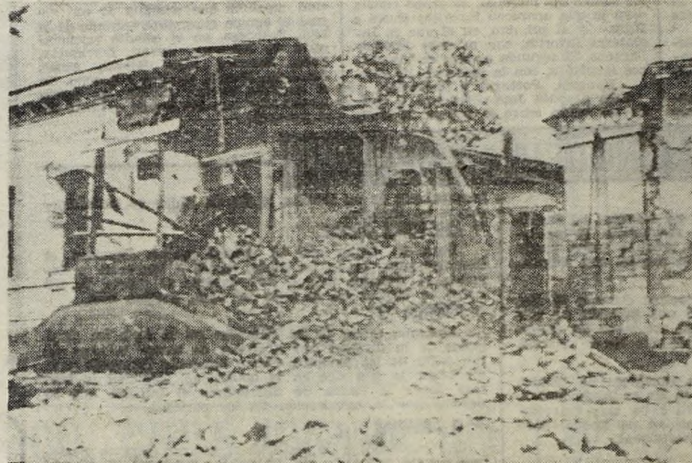
Los escombros de un edificio se amontonan en una calle de Tashkent, luego del violento sismo que estremeció a esta ciudad soviética y que causó la muerte de 4 personas y 150 resultaron heridas. (Radiofoto de Asoc. Press, especial para ULTIMA HORA).
